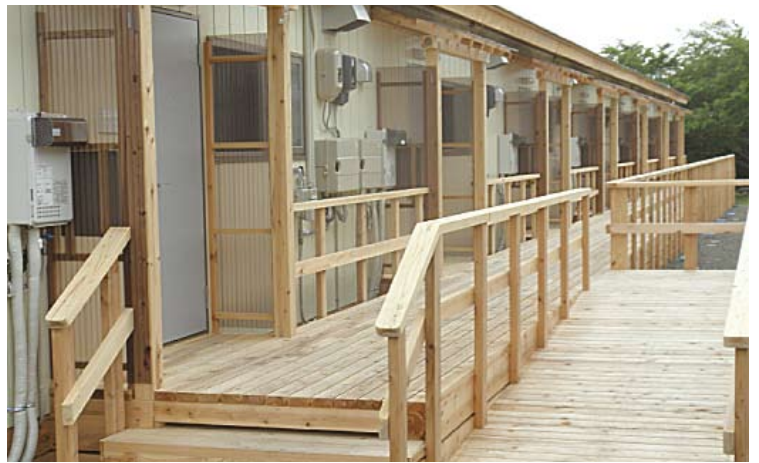
●弾力的につくられた木造仮設（七ヶ浜）
