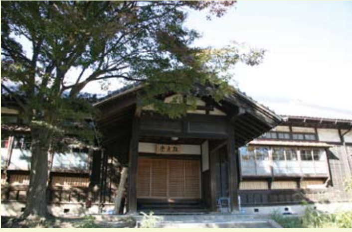
●「神戸大学武道場」全景
