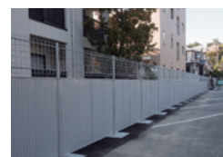
▲小学校囲障改修工事
