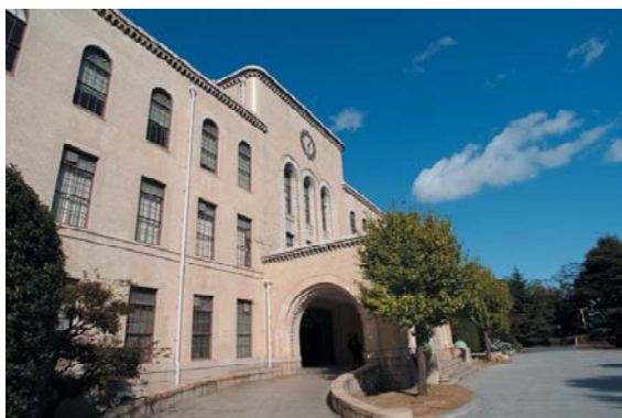
六甲台本館（昭和7年竣工）
