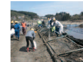
▲小友中学校の校庭片付け作業
