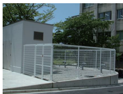
中和・曝気槽
