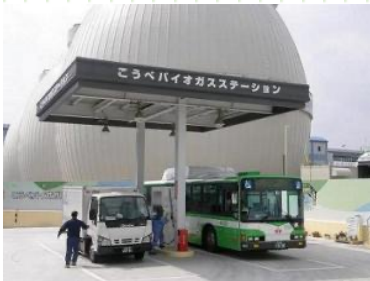
こうべバイオガスステーション
