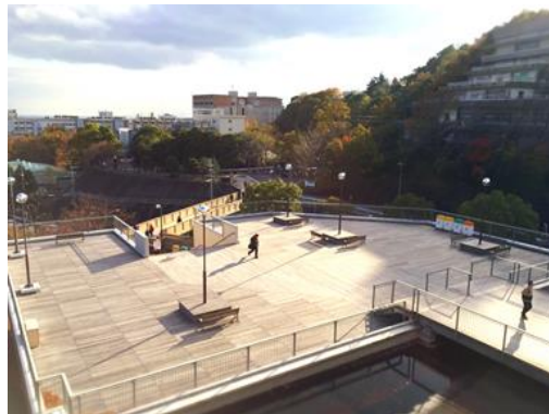
A棟1階 ウッドデッキ
