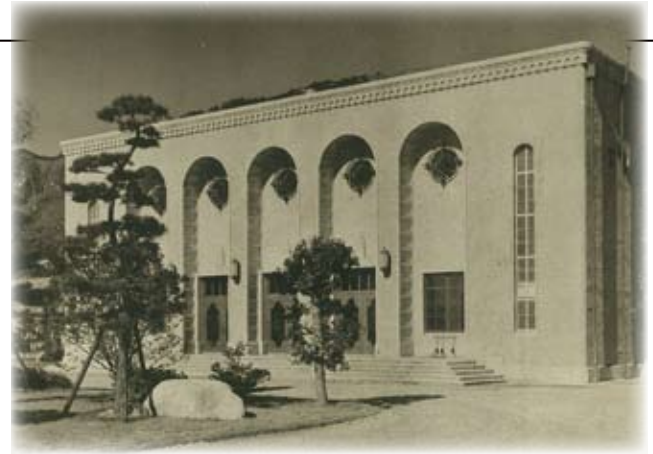
▲ 竣工まもなくの旧制神戸商業大学講堂 1937(昭和12)年頃
