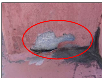
屋根 防水層の劣化
