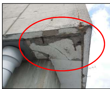
外壁 軒裏の欠損
