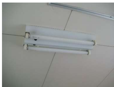
照明設備 老朽劣化
