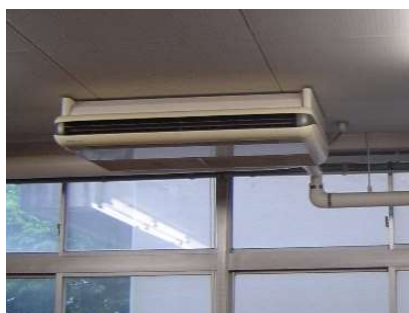
空気調和設備 老朽劣化
