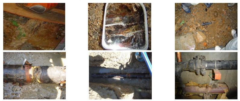
老朽した配管による漏水
