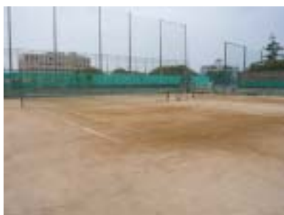
クレーコート改修
