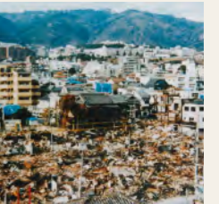
1995年 神戸大学付近の被災状況 上方に神戸大学の学舎が見える
