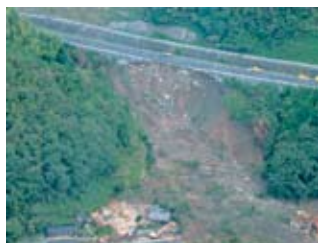
<写真1> 豪雨による道路の崩壊 (山陽自動車道岩国IC付近、2005年9月)
