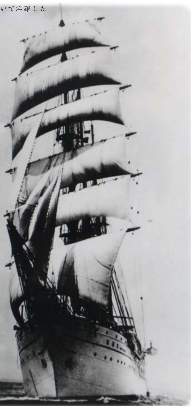
神戸高等商船学校練習船進徳丸。竣工時の総トン数2518.42t、全長109.1m、船幅13.41m。
