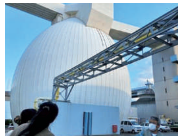
図2 メタンガス消化タンク
