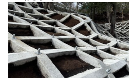
急傾斜地安全対策
