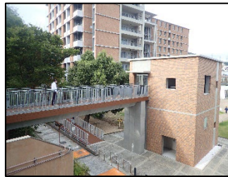
段差解消の取組 (エレベーター棟整備)
